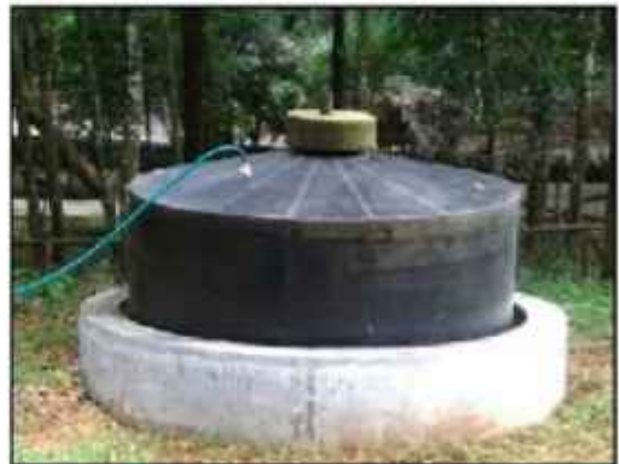
Fig. 5.21 Biogas digester
